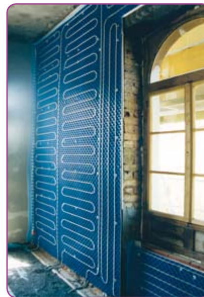
Figure 1.5 Exemple d'installation d'un système de mur rayonnant
