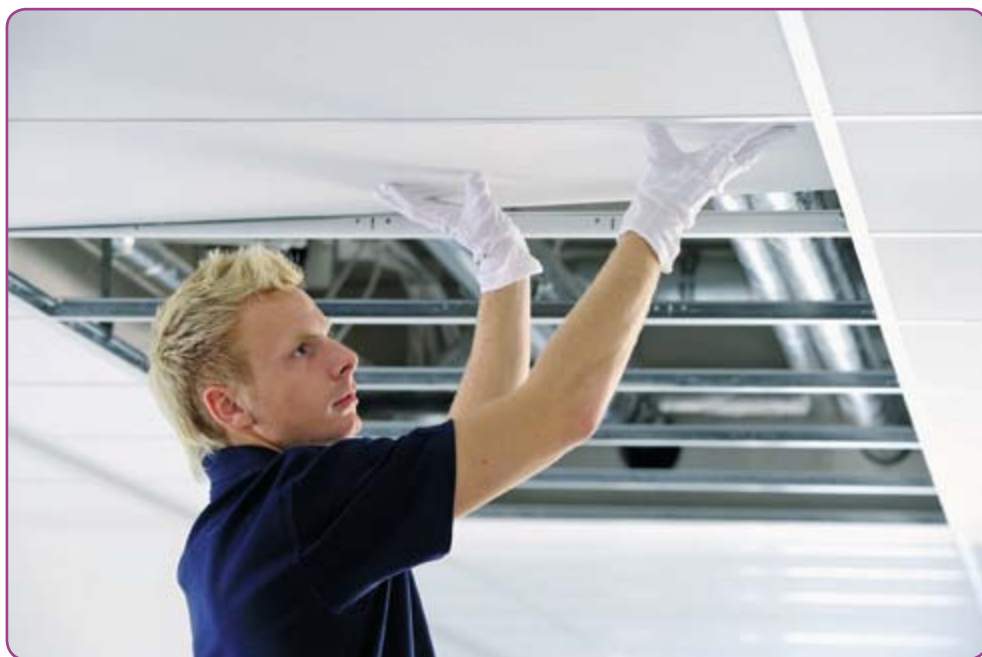
Figure 1.3 Exemple d'installation d'un système de plafond rayonnant
